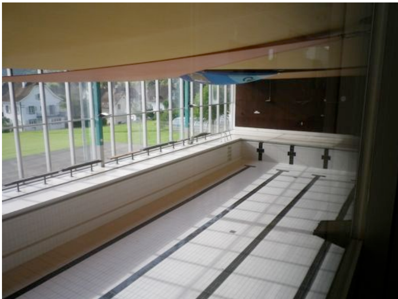
Abb. 1: Grosszügig wirkende Schwimmhalle mit Becken 25.0 m x 11.0 m, Wassertiefen von 1.40 m bis 1.80 m.
